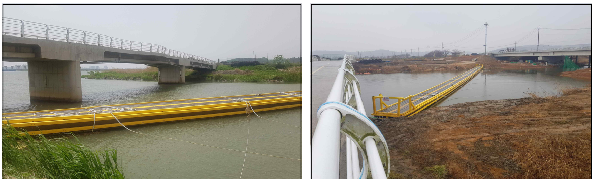
[그림 7-3] 육상기인 부유쓰레기 차단시설 설치사례 - 서천 길산천 하류
