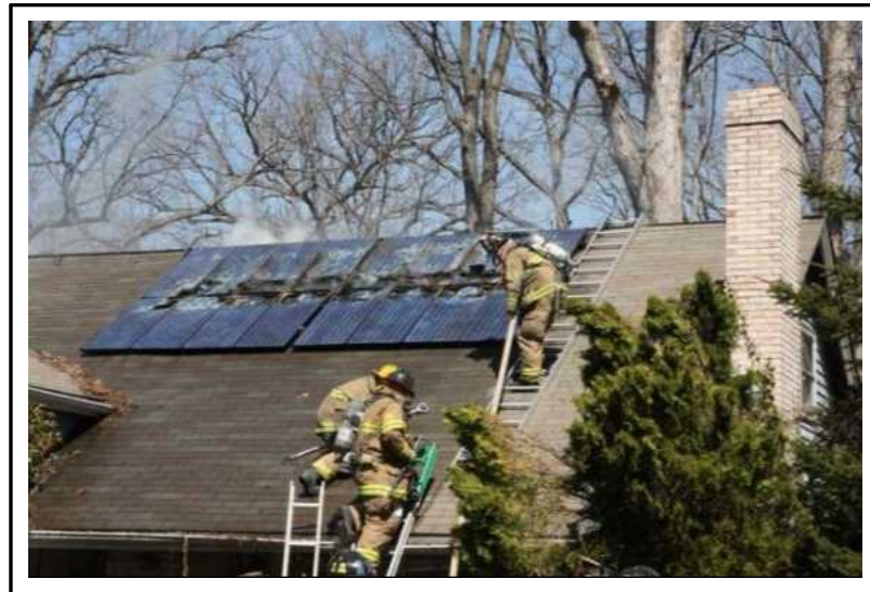
[그림 23] 인버터 결함으로 발생한 화재 사례
