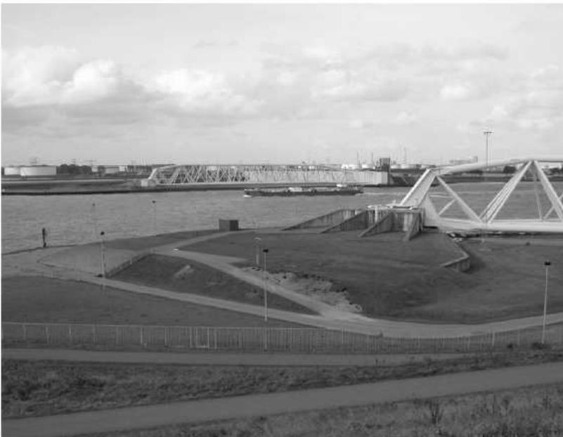
그림 1.2.2. 1997년에 완성된 네덜란드 마에스라트케링의 모습 (부채모양의 움직이는 댐이 평시에는 해안에 붙어 있다가 해일 경보 시에 닫히도록 설계되어 있음).
