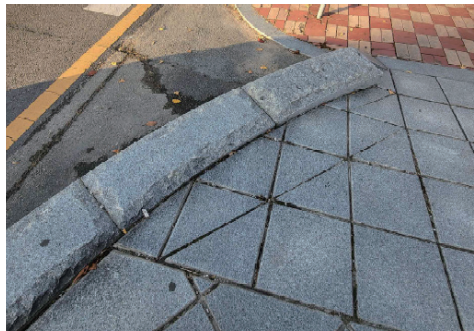
〈바닥재의 연속성 단절로 인한 단차 발생〉
